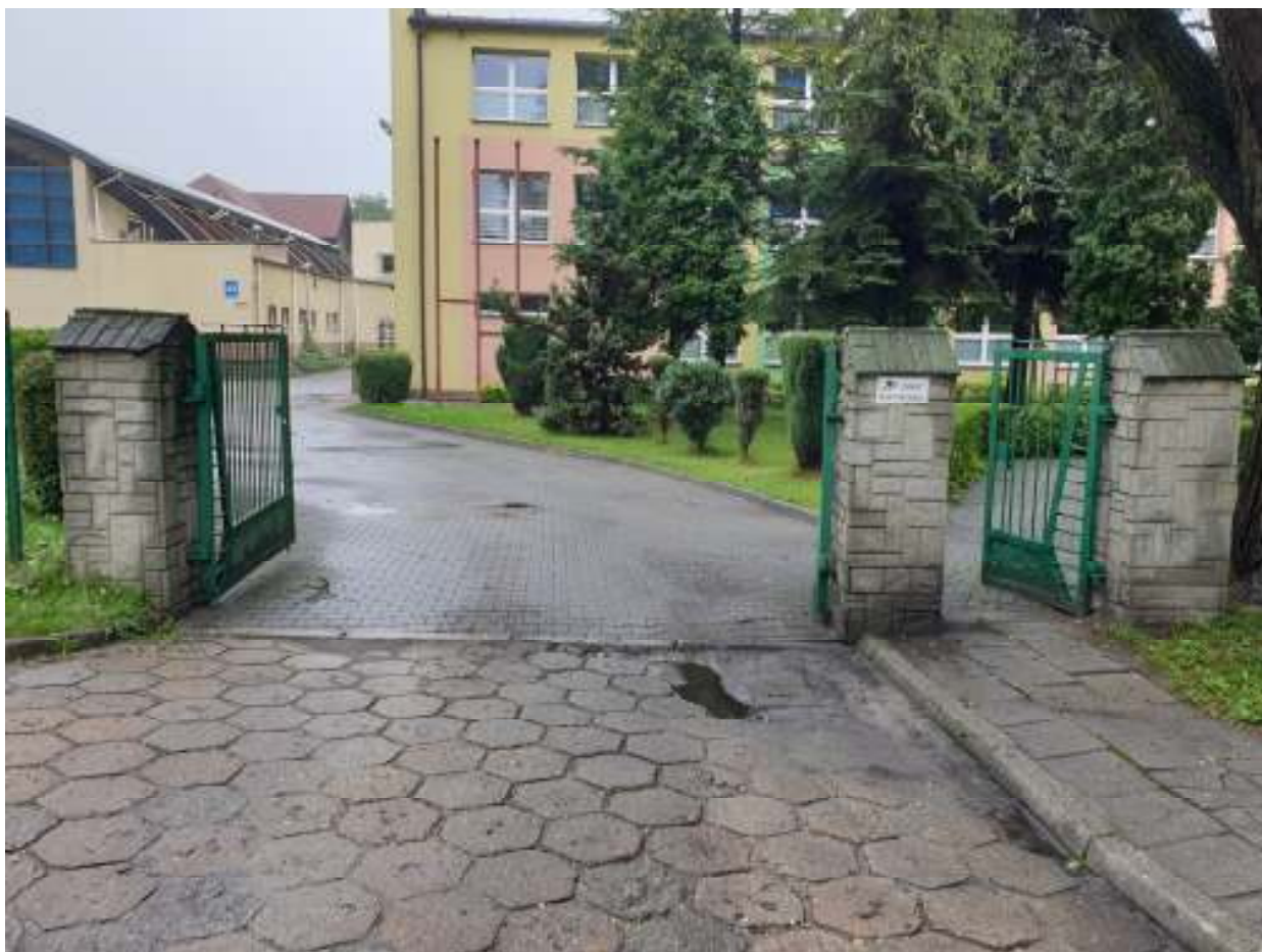
zdjęcie nr 1 – widok istniejącej bramy i furtki do rozbiorczy (źródło: własne).
